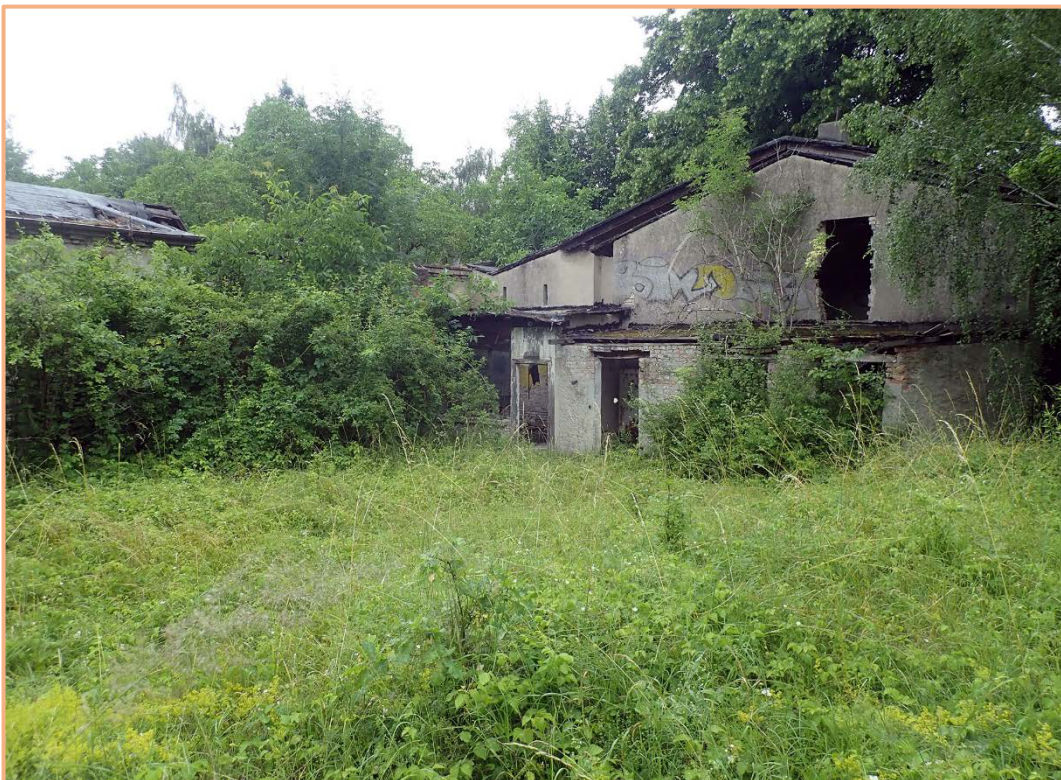
Abb. 32: Auf großen Teilen des Gebiets befinden sich ältere Brachen mit verfallenen Gebäuden (Aufnahme 08. Juli 2021).
