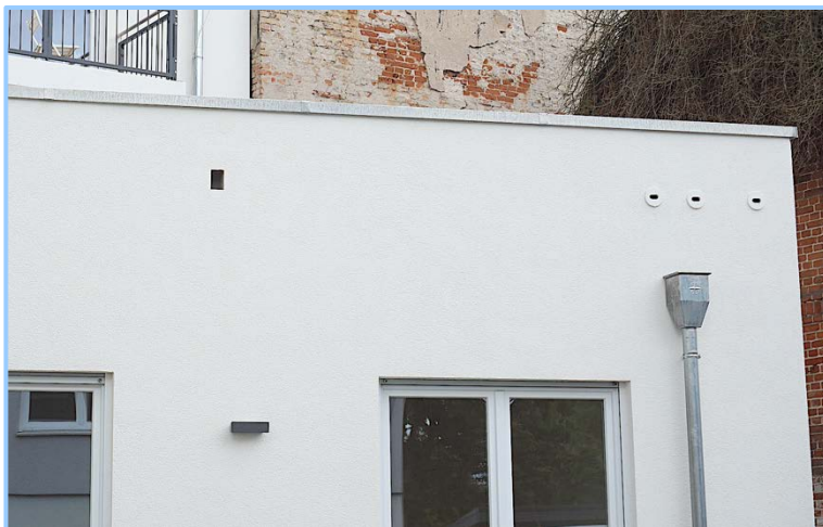
Abb. 53: Integration von einem Mauersegler- kasten 17A, dreifach und einer Halbhöhle 1HE für Hausrotschwänze in einen Neubau. Tino-Schwierzina- Str. 5 in Berlin-Heinersdorf, 2021.
