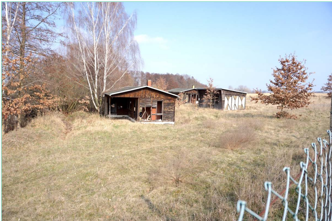
Abb. 11: Untersuchungsgebiet „Freizeit und Erholung am Trebelsee“ in der Gemeinde Groß Kreuz: Abrissobjekte im Osten der Planfläche (März 2021).
