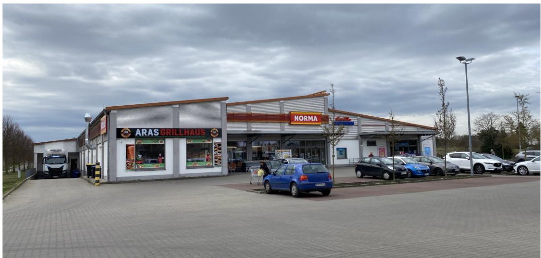
Abbildung 11: Norma-Lebensmitteldiscounter an der Potsdamer Straße 46b
