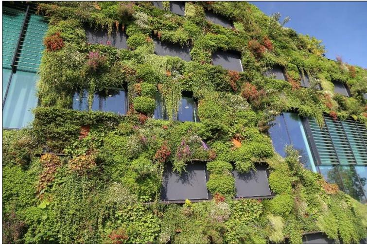
Abbildung 8: Beispielhafte Abbildung einer fassadengebundenen Gebäudebegrünung; Aufnahme H. Roßmann
