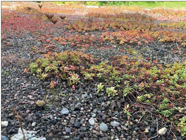
Abbildung 6: Beispielhafte Abbildung einer extensiven, sedumdominierten Dachbegrünung; Aufnahme H. Roßmann 09/2022
