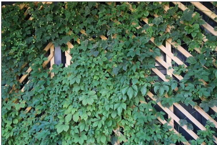
Abbildung 7: Beispielhafte Abbildung einer bodengebundenen Fassadenbegrünung; Aufnahme H. Roßmann 09/2022
